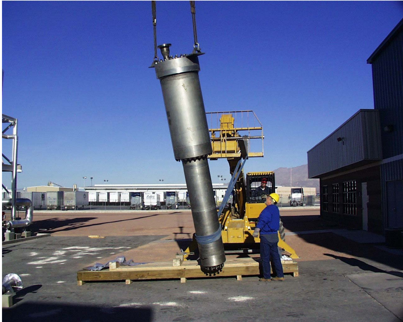
Hermetic LNG Pump, After ACD, Inc.
